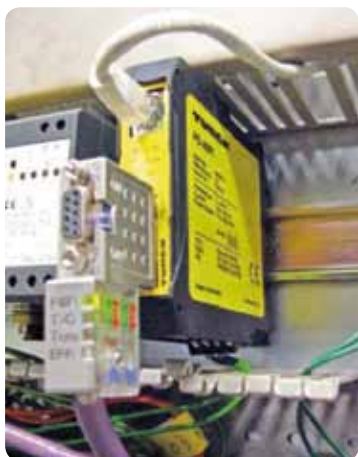
Obr. 1 Rozhranie pre ethernet a webový server umožňuje PB-XEPI centrálné monitorovanie siete Profibus.
